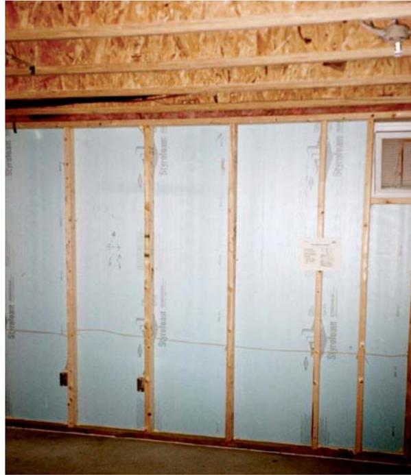
**Figure 2 - Exterior Walls 2" x 6" Studs 24" Stud Spacing**
