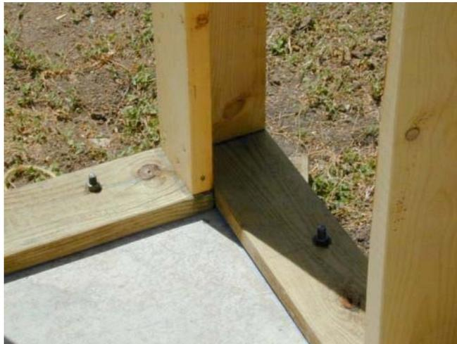
**Figure 3 - Exterior Walls 2-Stud Corners**
