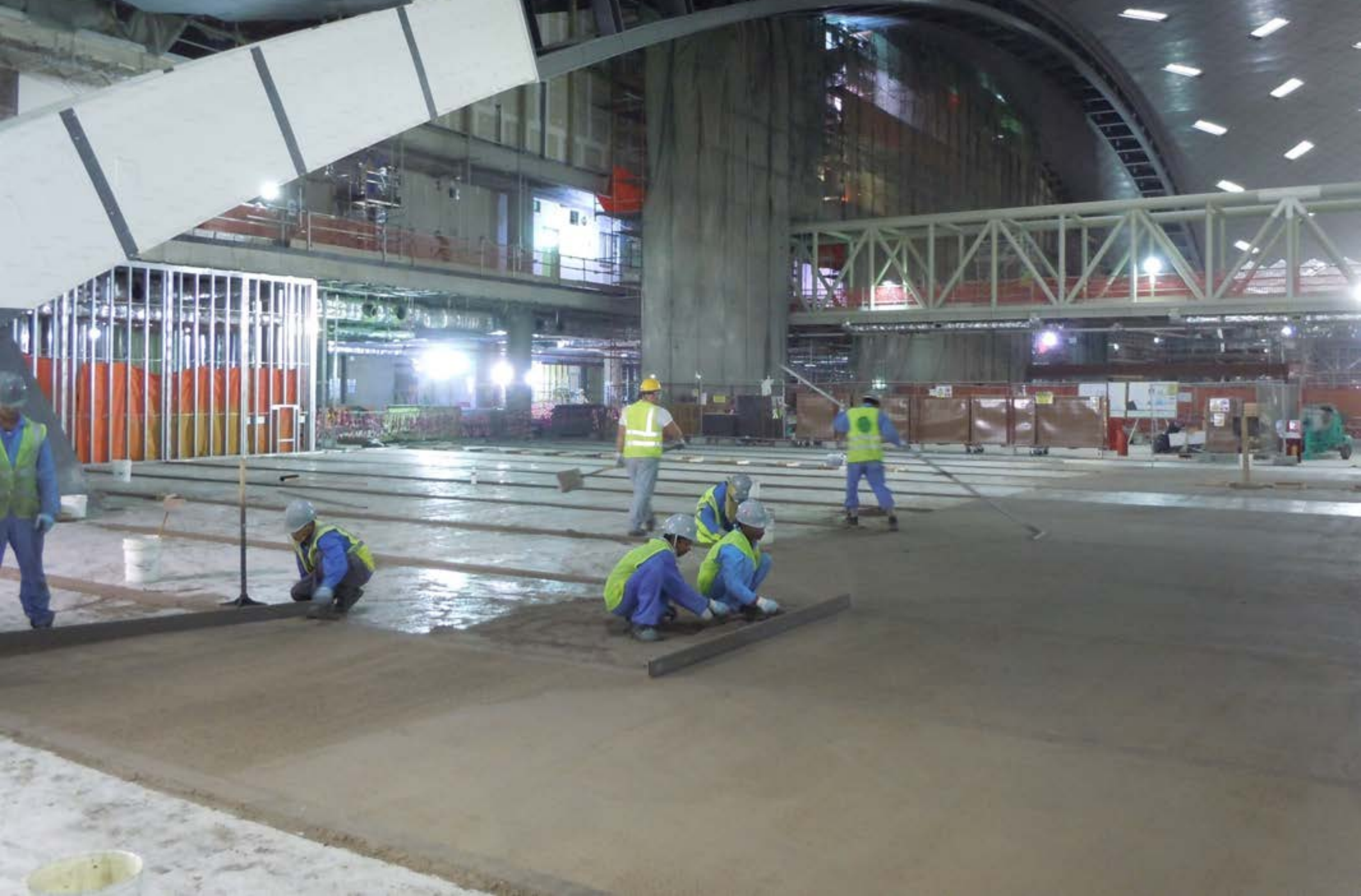
Mortar Fill - Epoxy & Sand
